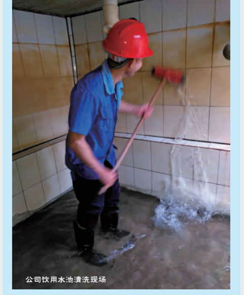
公司饮用水池清洗现场
