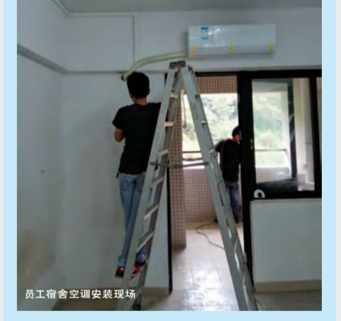
员工宿舍空调安装现场
